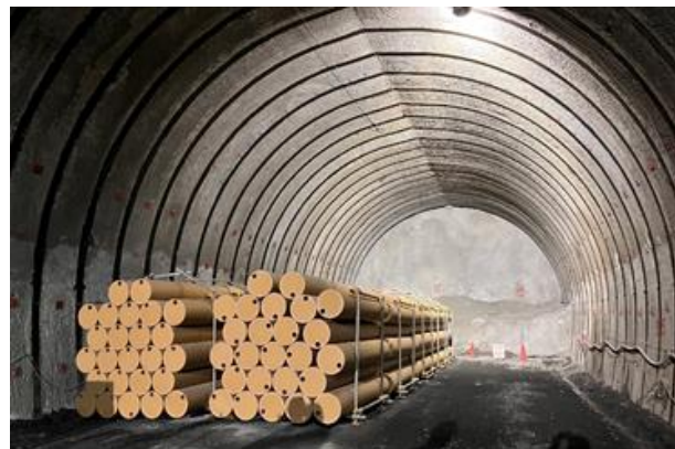
トンネル工事現場に設置する様子
