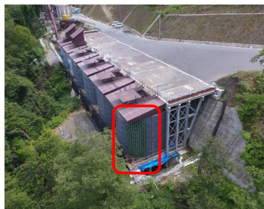
骨材貯蔵設備へのクールシート設置状況 (赤枠箇所:クールシート)
